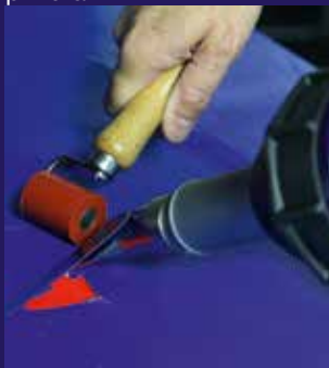
Soldadura de parche
