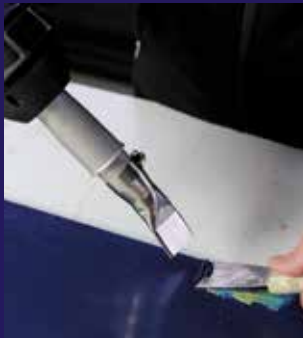
Aplicación de capas de pintura
